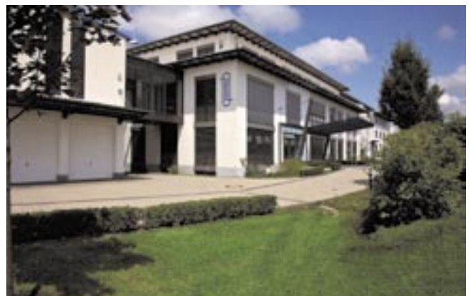
Hummel-Verwaltungsgebäude am Hauptsitz im südbadischen Denzlingen.
